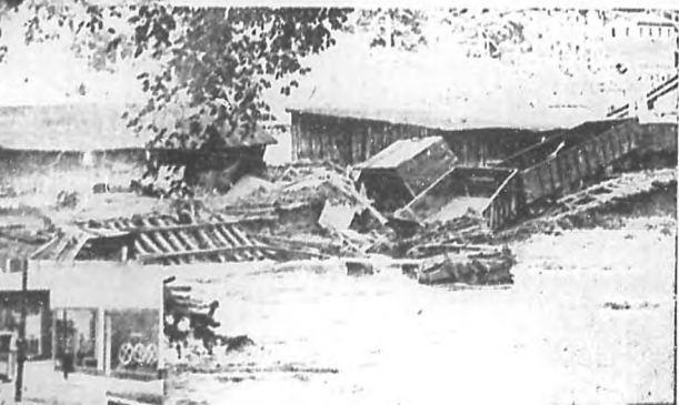
LAS INUNDACIONES DE CHARLESTON. —Un aspecto de los daños producidos por las grandes avenidas de agua que costaron dieciocho vidas y dos y medio millones de pesos de pérdidas.
